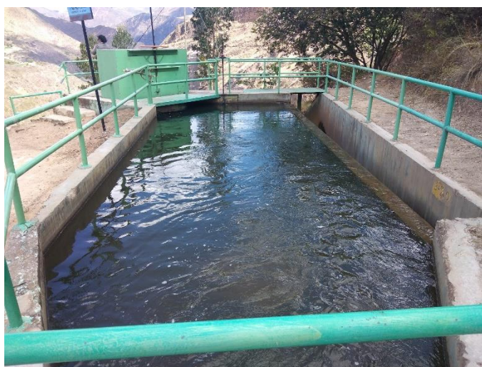
Figura 4. Cámara de carga
