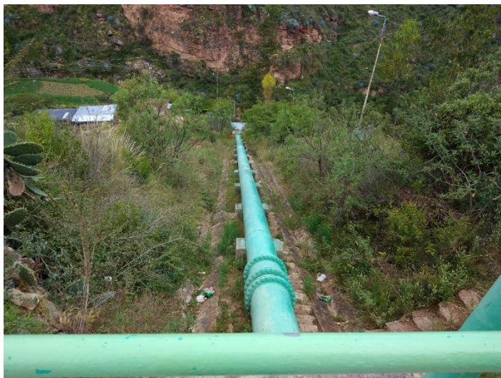
Figura 5. Tubería forzada
