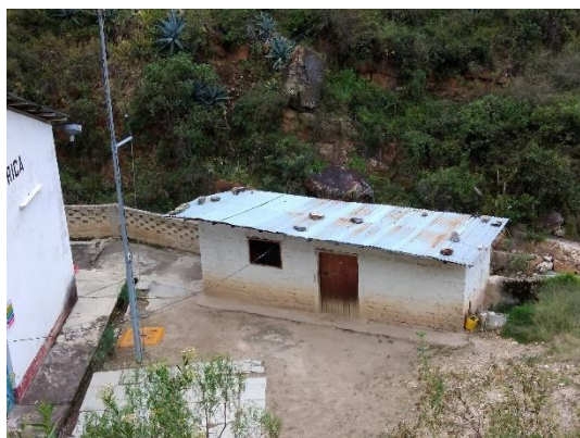
Descripción: caseta de vigilancia
