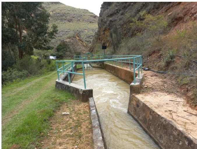
Figura 3. Desarenador
