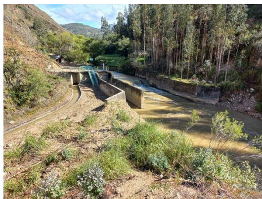
Descripción: toma de captación
