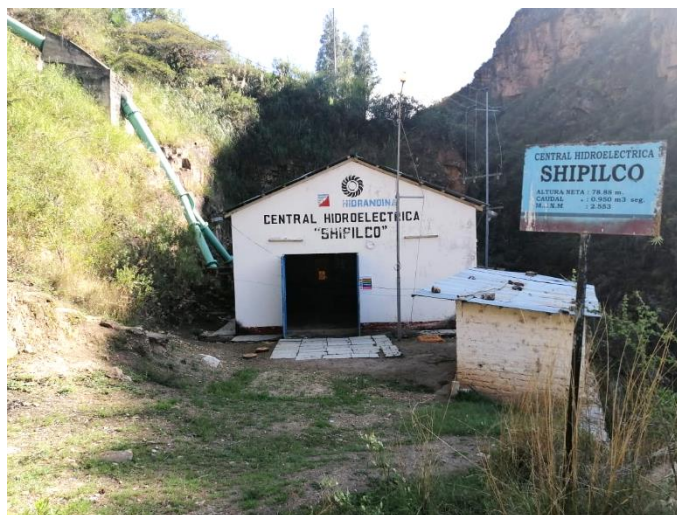
Figura 6. Vista externa de la sala de máquinas
